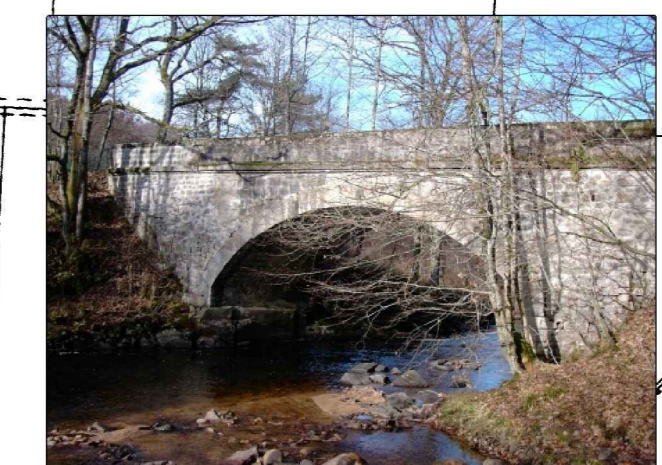
La Cure au droit de l'air de poutres
